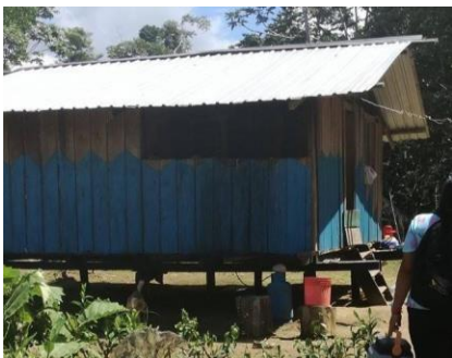
Vivienda de madera
