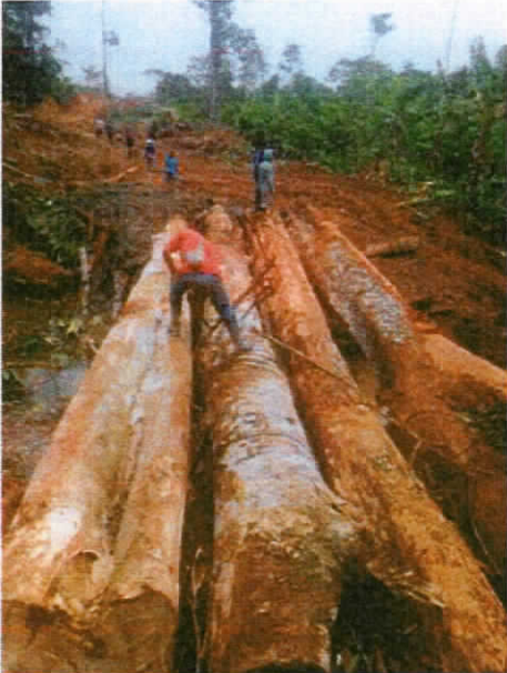
COLOCACION DE PUENTE DE MADERA RIO QUILLU YAKU
